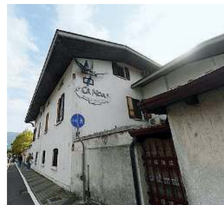
Ore contate. La Ca' Nöa sarà demolita
